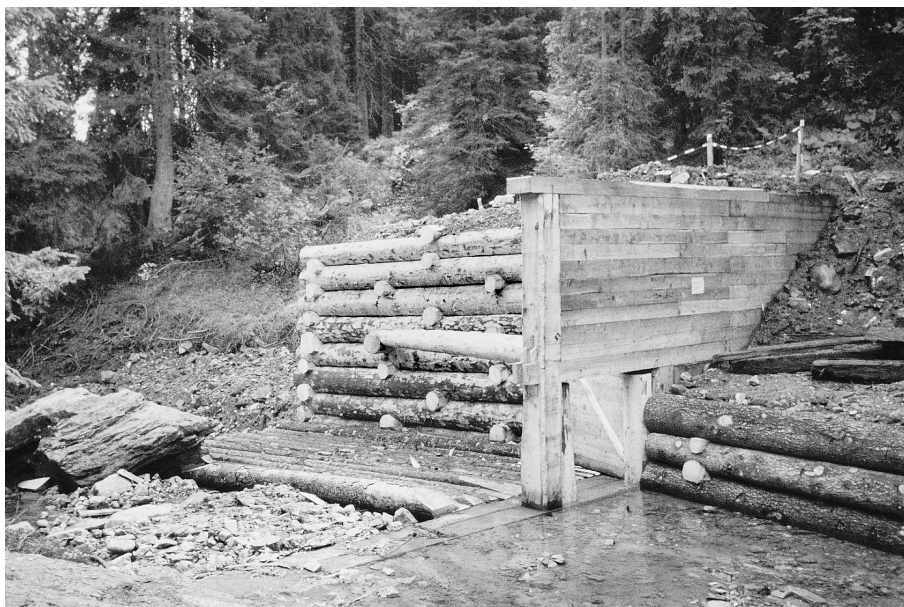
Chluis im Dersmatt: Neuer Unterbau, rechte Hälfte in originaler Grösse neu erbaut.
