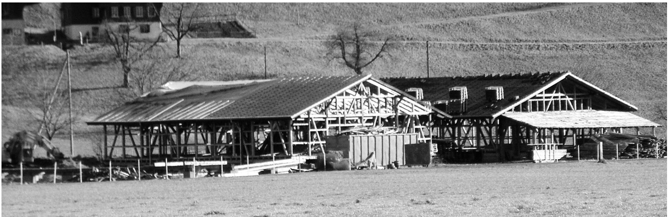
Die letzten zwei Baracken sind entziegelt und haben bereits Durchzug.
