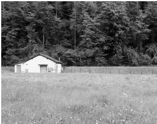
Häuschen und Tankanlage seit rund 70 Jahren, jetzt alles eingeebnet.
