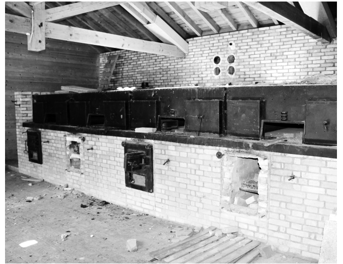
Grosse Backanlage mit vier Öfen
