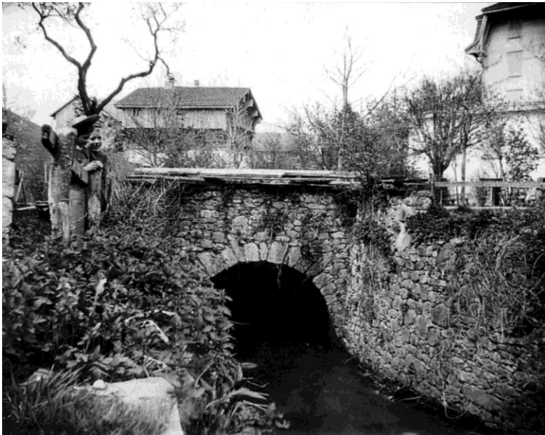
Bild 5: Alter Stolleneinlauf Richtung Süden, wie er im Jahre 1767 erstellt wurde. Im Hintergrund das Heimwesen Talacheri. Bis dort wurde der Stollen im Tagebau erstellt und später wieder mit Erdreich überdeckt. Hier, wie auch am Nordportal wurden die ausgebrochenen Steine der Burgruine Rudenz verbaut.
