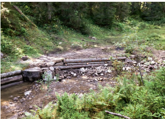
Gelungene Böschungssicherung
