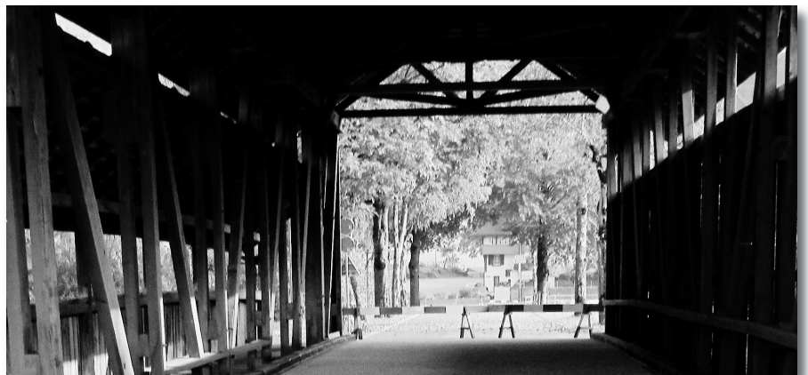
Der neue Belag ist eingebracht
